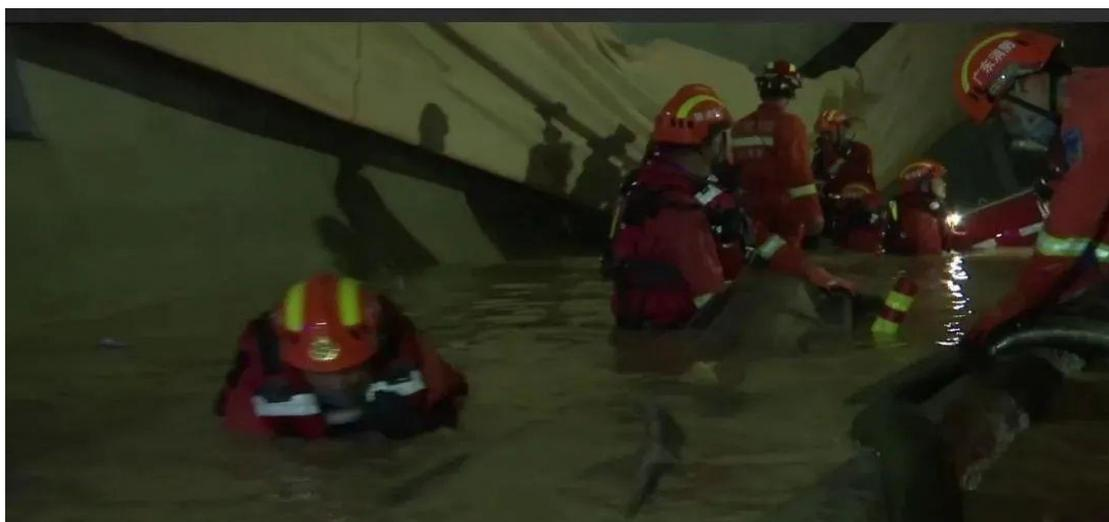
2021年7月15日3时30分，广东省珠海市香洲区兴业快线石景山隧道右线施工过程中，掌子面拱顶坍塌，诱发透水事故，造成14人死亡，直接经济损失3678.677万元。
